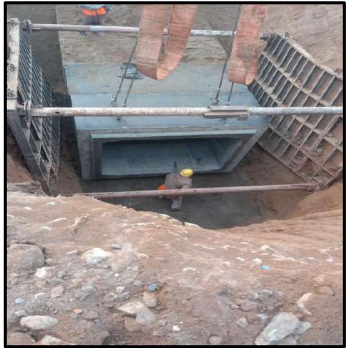
Picture 79: Conduit Laying
